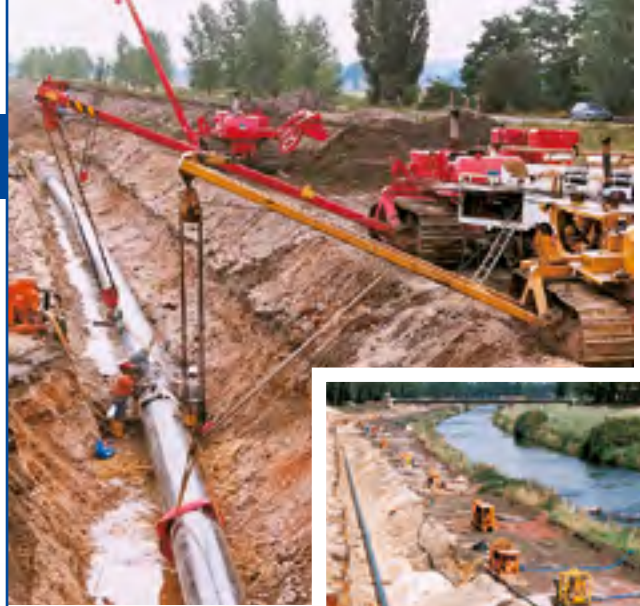
Verlegung von Gasleitungen
