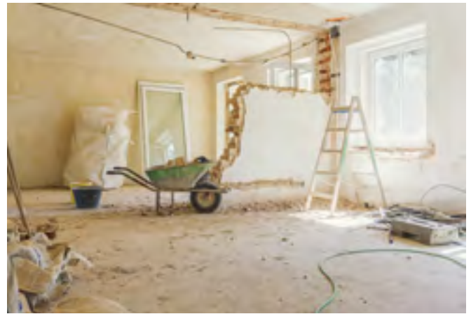
Abbrucharbeiten in der Wettiner Straße
